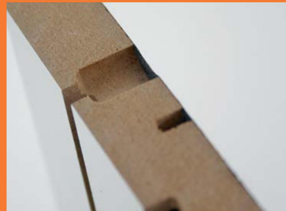
Sezione del risonatore di Helmholtz nel 4akustik.
